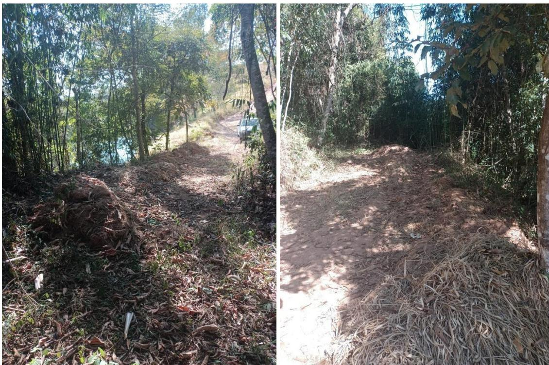
Fig. 347 e 348. Solo proveniente de obras no aceiro, depositado indevidamente na trilha e formando recalque. (SEMAM)
